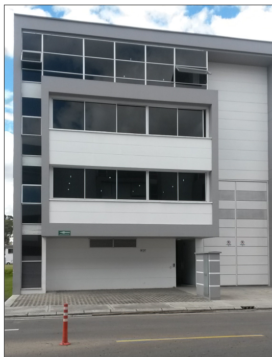
Bodega que concentra el archivo judicial y administrativo de la Jurisdicción Especializada, ubicada en el Parque Empresarial Puerta del Sol de la ciudad de Bogotá, D.C.
